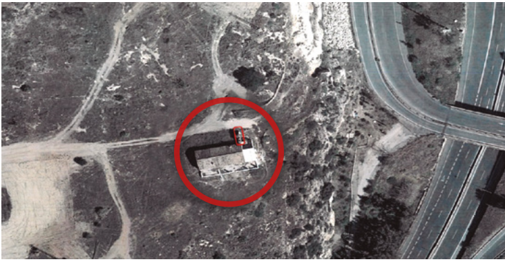
EL CAMINO VIEJO DE VÉLEZ Y LAS EDIFICACIONES EXISTENTES OBJETO DEL INFORME
