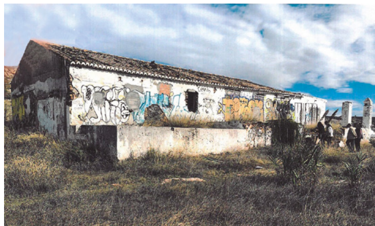
EDIFICACIONES EN EL CAMINO VIEJO DE VÉLEZ. LA QUE ALGUNOS HAN CONSIDERADO POSIBLE CASA DE POSTAS. ESTADO ACTUAL
