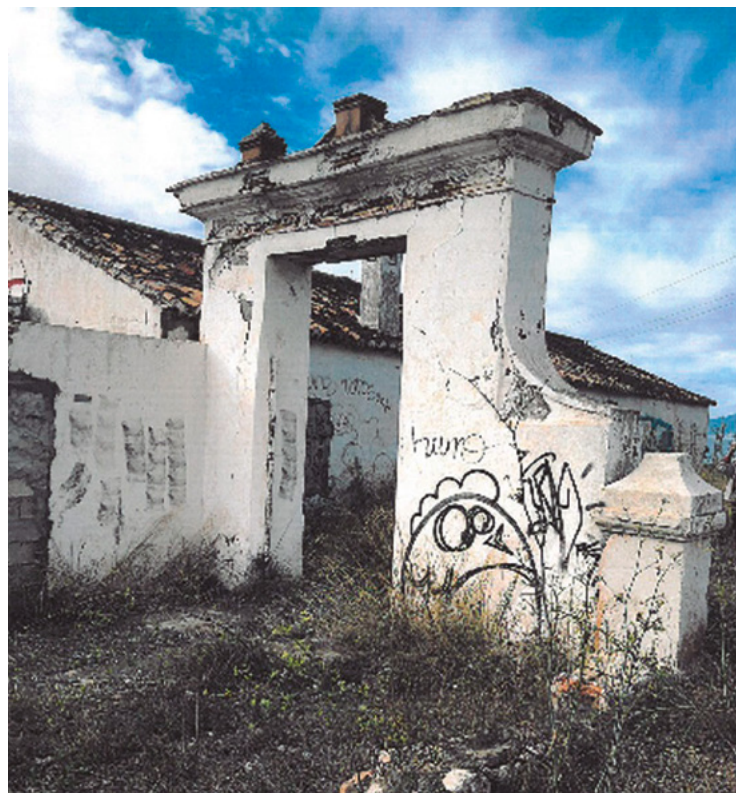
EDIFICACIONES EN EL CAMINO VIEJO DE VÉLEZ. PUERTA MONUMENTAL. ESTADO ACTUAL
