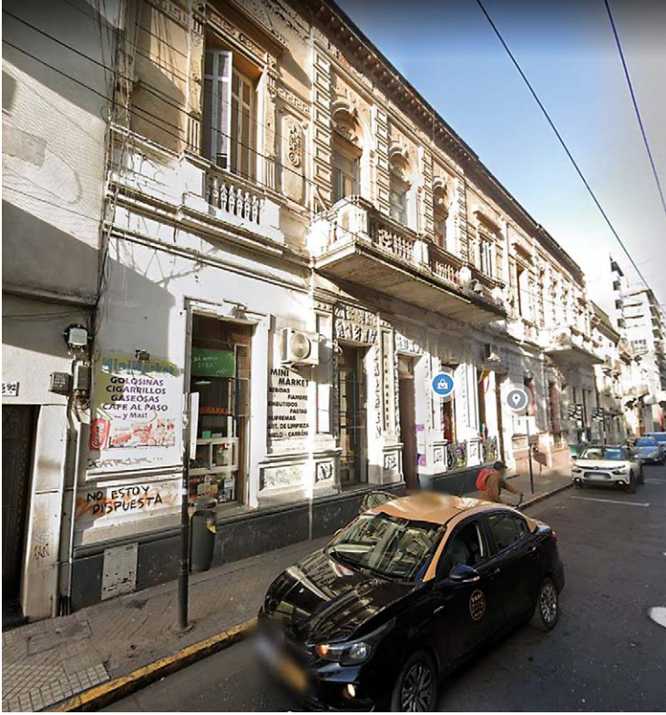
DOMICILIO DE BARTOLOMÉ DELGADO BIEDMA EN CALLE SAN JUAN, ROSARIO DE SANTA FE
