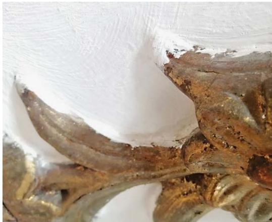
FIG. 17. DESPERFECTOS EN LA RESTAURACIÓN DEL CAMARÍN. RETOQUE DE PINTURA EN LA PARTE SUPERIOR DE LA MOLDURA FLORAL
